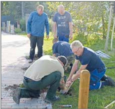
Der neuen Lattenzaun und die "Modder-Sicherung" stehen nach dem Arbeitseinsatz in der Kita. Fotos: Kita Barleben
