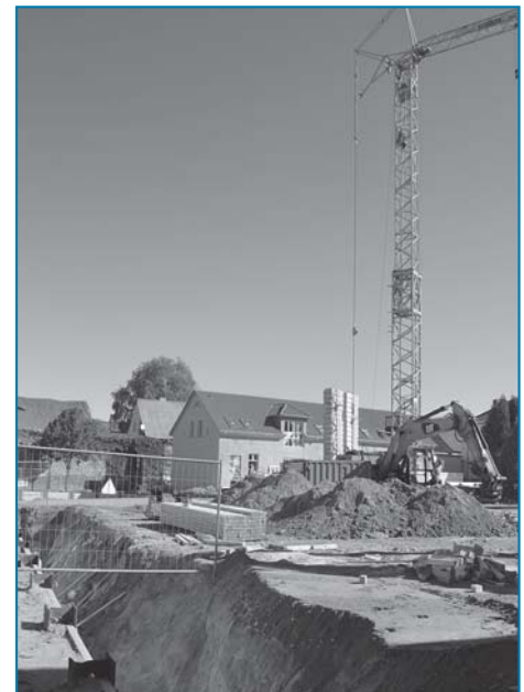
Auf dem Grundstück Breiteweg/Ecke Rudolf-Breitscheid-Straße der Ortschaft Barleben wird derzeit tüchtig gebaut. Foto: psk
