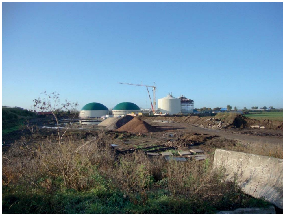
Abb. 16: Biogasanlage in Ebendorf
