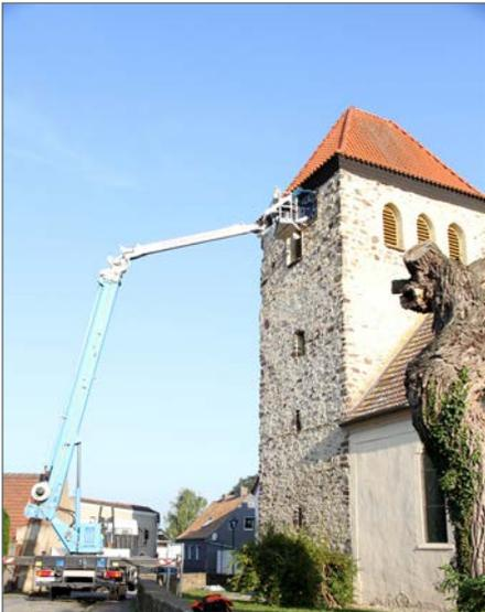
Nach der Restaurierung haben Mitarbeiter einer Spezialfirma das Ziffernblatt wieder auf das noch vorhandene Uhrwerk im Turm der Ebendorfer Kirche montiert. Fotos:tz
